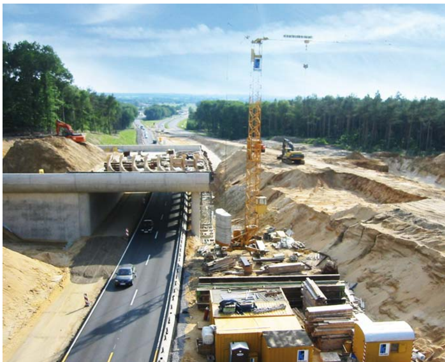
Ecoduct A 52 (D) tussen Elmpt en Roermond. Wildbrücke über die A 52 (D) zwischen Elmpt und Roermond.
